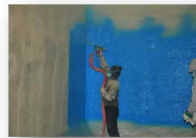
▲ JET SPRAY 시공
