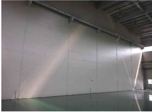
현장 시공 사례
