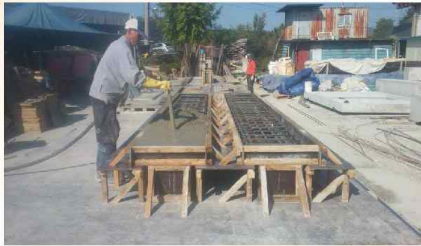
(c) 콘크리트 타설
