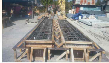
(b) 철근배근 및 거푸집 설치
